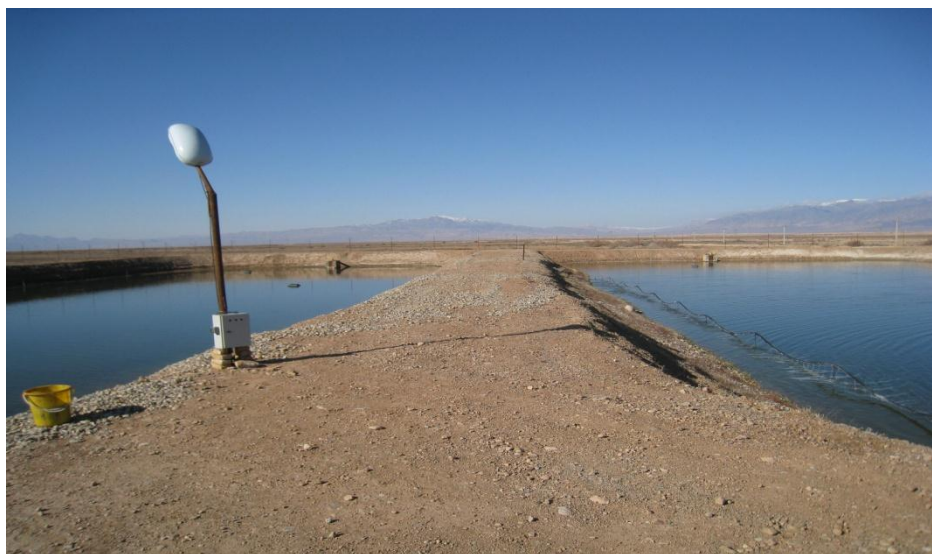
شکل - دیواره بین استخرهای خاکی ( تاج استخر ) و سیستم روشنایی مستقر در استخرها
